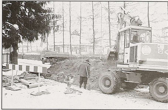
Roboty prowadzono nawet w zimie
