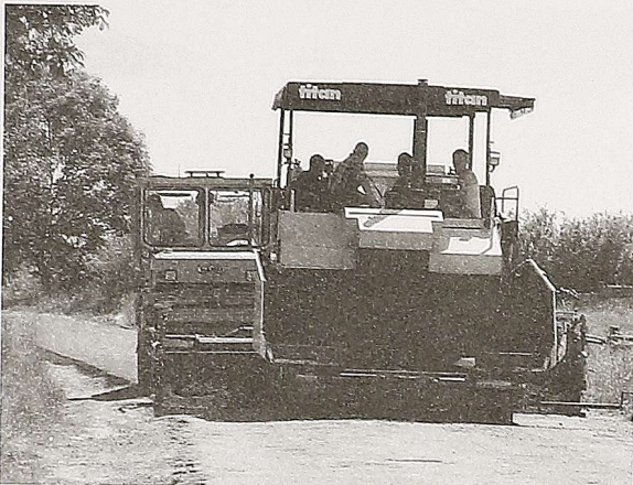
Prace na drodze powiatowej w Michniowcu
