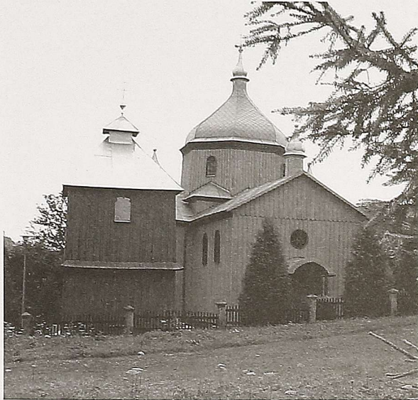
Cerkiew w Brelikowie będzie jednym z ciekawszych obiektów ekomuzeum „Z okrucich tworzymy historię” Fot. T. Szewczyk
