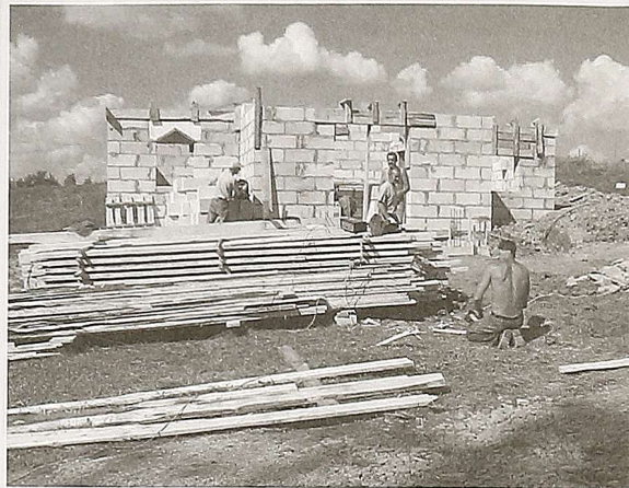
Na razie pogoda budowniczym kaplicy sprzyja
