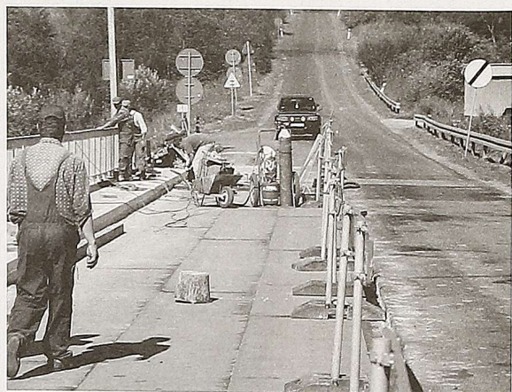
Na czas robót pół mostu wyłączono z ruchu
