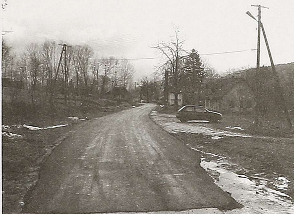
Nowy odcinek ul. Strwiążyk jest już gotów
