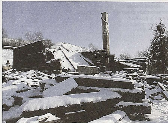
Dom trzeba budować od początku
