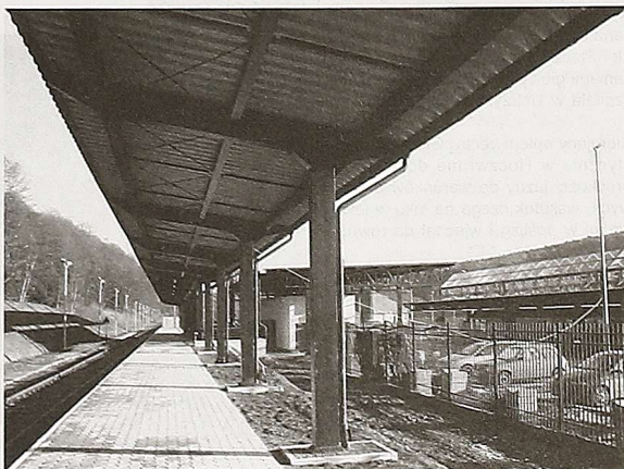
Jeśli Ukraińcy nie będą przyjeżdżać, to nowy terminal kolejowy na przejściu w Krościenku będzie słabo wykorzystany Fot. T. Szewczyk
