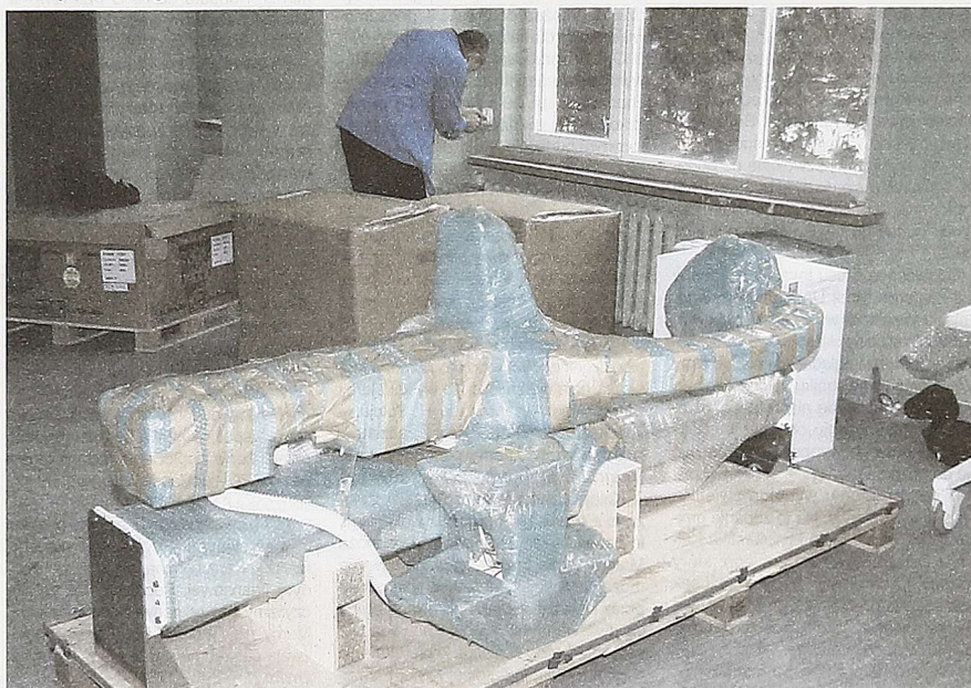
W odremontowanej pracowni rentgenowskiej rozpoczęła się instalacja nowej aparatury
