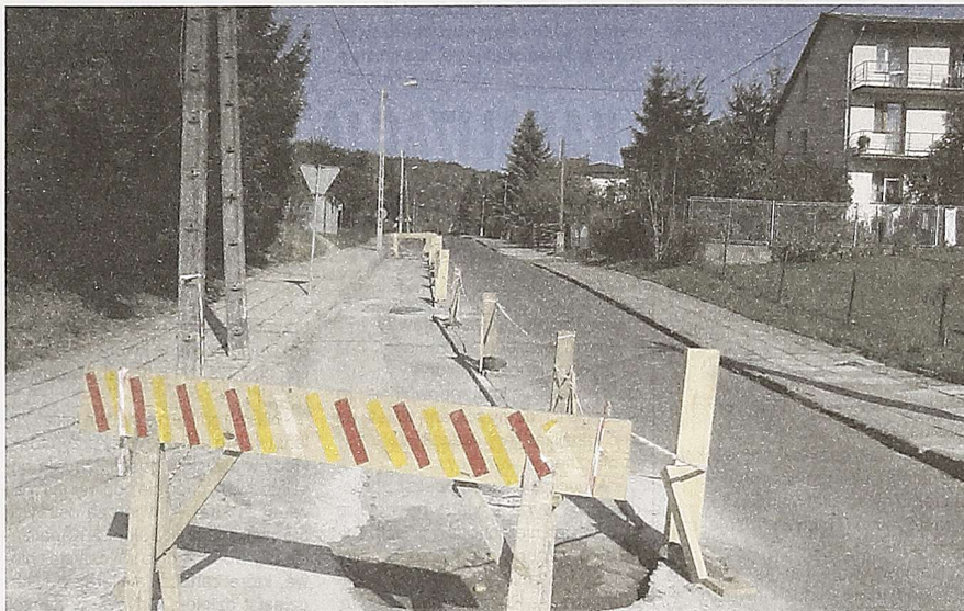
Roboty kanalizacyjne przy ul. Nadgórnej ledwo się zaczęły, a już się skończyły
