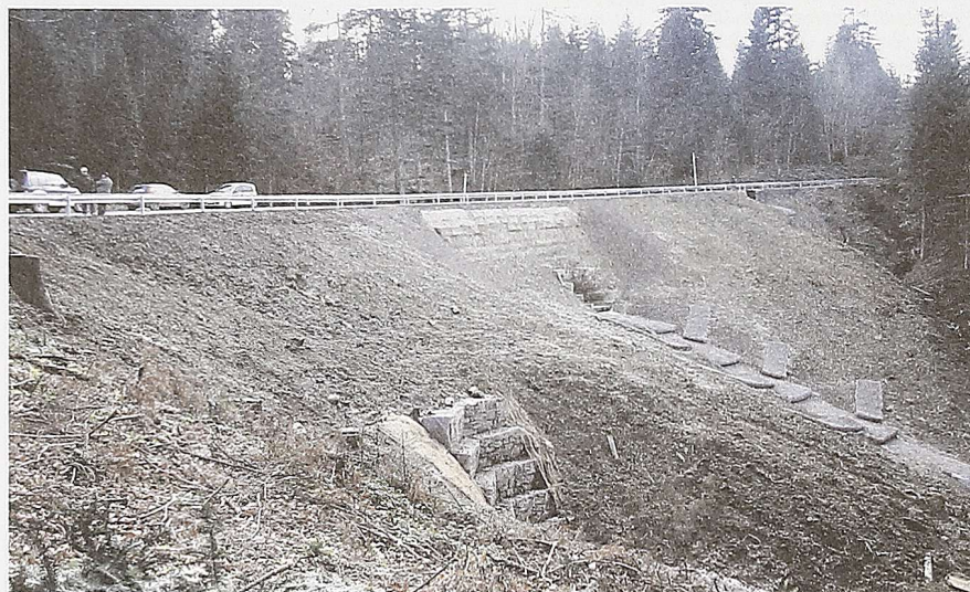
Prace przy likwidacji usuwiska zakończyły się oficjalnie 2 grudnia
