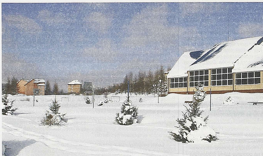
Na wiosnę plac przy MKP „Delfin” stanie się placem budowy
