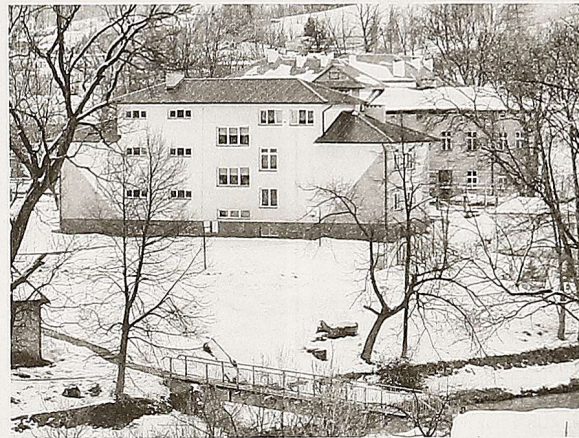
Na tym placu stanie hala sportowo-widowiskowa
