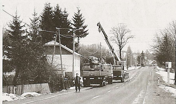
Energetycy już kończą przebudowę linii
