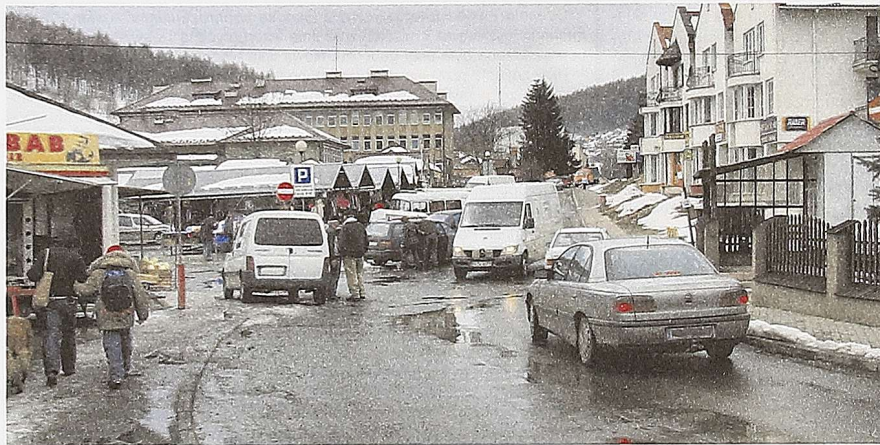
Jedną z tegorocznych inwestycji ustrzyckich będzie przebudowa ul. Korczaka
