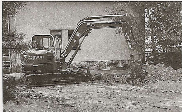
Połowa prac została już wykonana Fot. T. Szewczyk
