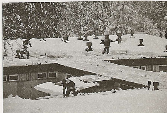
Ciężki, śnieg groził zawaleniem płaskiego dachu na ustrzyckim przedszkolu nr 2. Zagrożenie to usunęli strażacy z OSP w Łodynie Fot. M. Szewczyk
