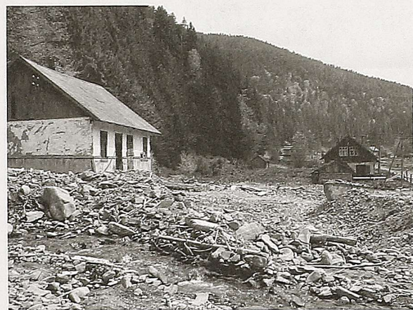
Część opuszczonych domów w Burkucie uległa rujnacji Fot. A. Dumkiewicz
