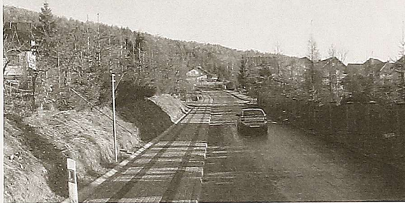
Remont i przebudowa kanalizacji, chodników i nawierzchni ul. W. Pola pochłony 840 tys. zł Fot. T. Szewczyk
