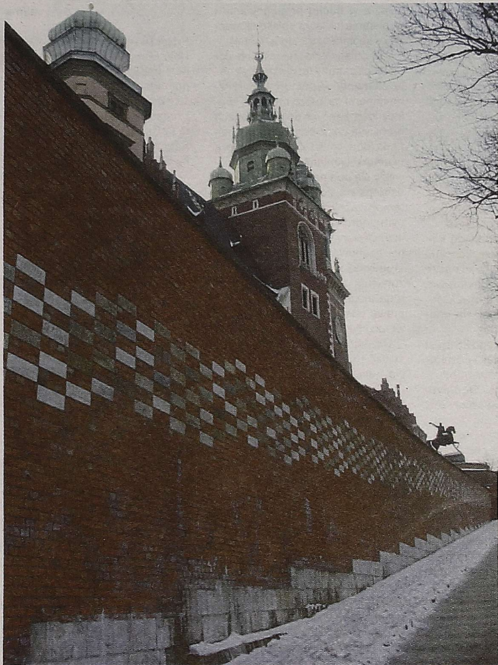
Mur oporowy na Wawelu z cegielkami darczyńców
