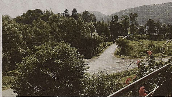
Uszkodzona przez powódzie droga w Zwierzyniu zostanie wyremontowana Fot. I. Pojnar
