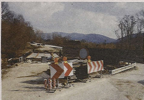
Przebudowa mostu na Wetlinie trwa
