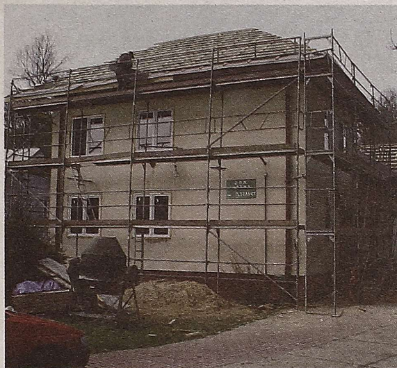
Nowy dach lada dzień będzie gotów
