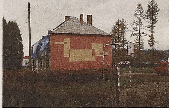
edną z najważniejszych inwestycji, do jakich przymierza się Olszanica, będzie budowa sali sportowej przy ZSP w Uhercach Mineralnych
