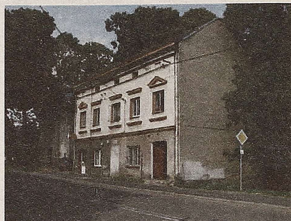
W tym budynku w Baligródzie mieścił się posterunek MO Fot. W. Cieślak
