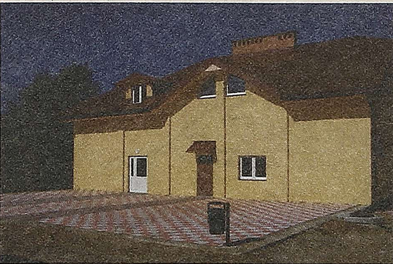
Po 16 latach trwania w stanie surowym zamkniętym budowa świetlicy wiejskiej w Stężnicy wreszcie została sfinalizowana Fot. M. Mazur
