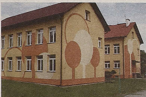
Szkoła Podstawowa w Hoszowie - termomodernizacja
