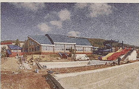
Budowa basenów odkrytych
