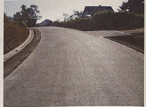
Uł. Wiejska - rządowy program budowy dróg lokalnych.
