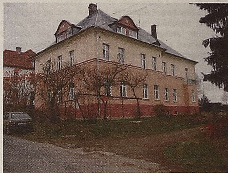
Ul. Naftowa 4 - budynek komunalny
