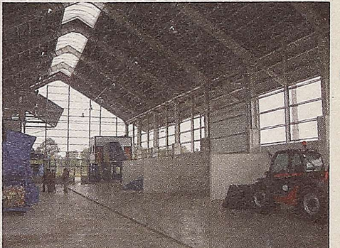
Sortownia śmieci ze stacją przeładunkową
