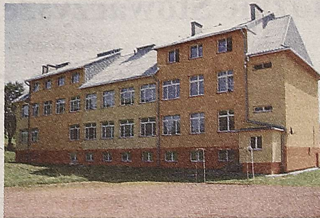
Szkoła Podstawowa w Łodynie - termomodernizacja
