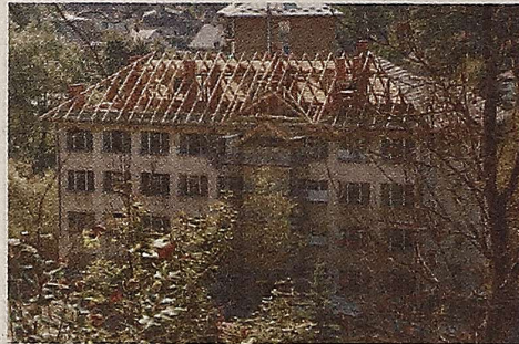
Rozpoczęła się adaptacja budynku b. MZRB na mieszkania komunalne
