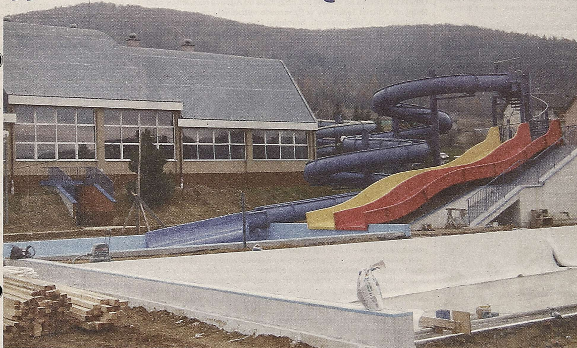
Budowa kompleksu sportowo-rekreacyjnego przy MKP „Delfin” znalazła się na finiszu
