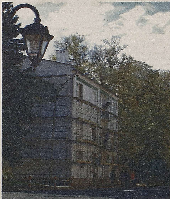
Prace przy termomodernizacji BDK przebiegały sprawnie Fot. T. Szewczyk
