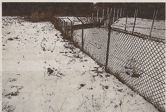
Miejsce, w którym doszło do wypadku
