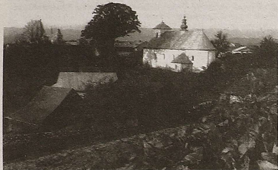
Dąb przy cerkwi (ok. 1910 r.)
