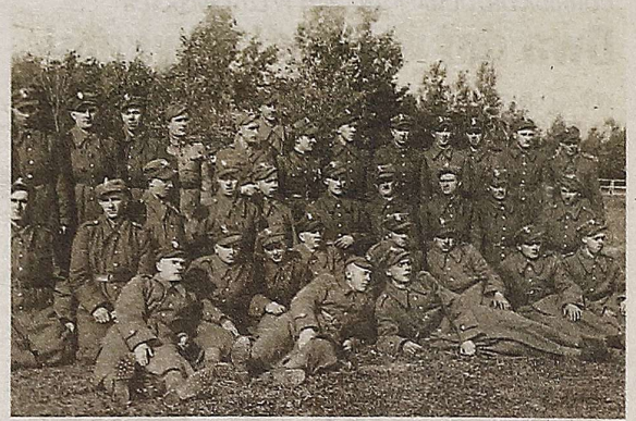
Baligród. Wopisanci 37 Komendy Odcinka
