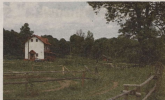
Lipowiec. W głębi strażnica WOP po przebudowie
