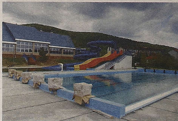
Niecki basenu sportowego i rekreacyjnego są już wypelnione wodą
