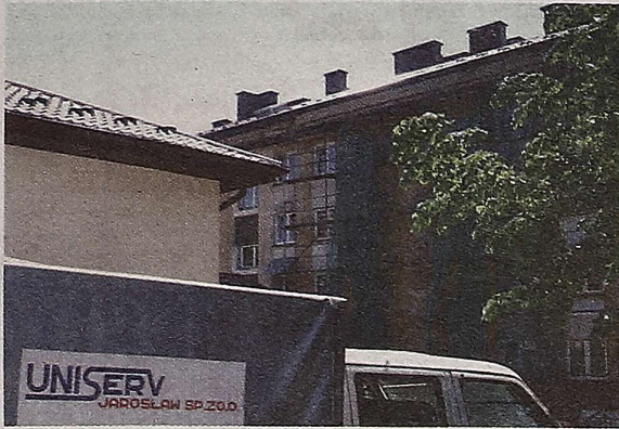
Przebudowa dachu idzie w dobrym tempie
