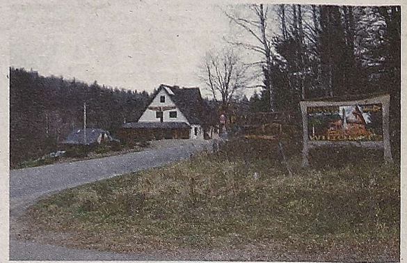
Remont drogi w Przysłupiu ma się zakończyć jeszcze w czerwcu
