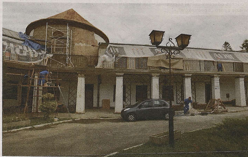
Prace remontowe leskiego zamku idą pełną parą
