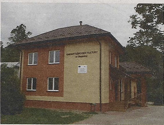
W ub.r. dzięki wsparciu z PROW zmodernizowano GOK w Olszanic
