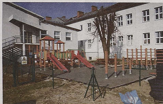
Prace przy budowie placu zabaw zbliżają się do końca
