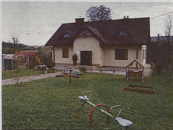
Kilka lat temu w Weremieniu wybudowano funkcjonalną świetlicę wiejską Fot. T. Szewczyk
