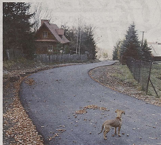
Podgłębokie prawie gotowa. Zostało jeszcze wyrównanie poboczy
