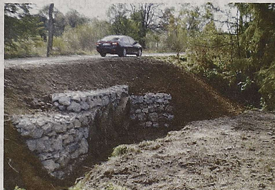
Wyremontowany przepust pod drogą przez Hoszowczyk Fot. A. Krystian
