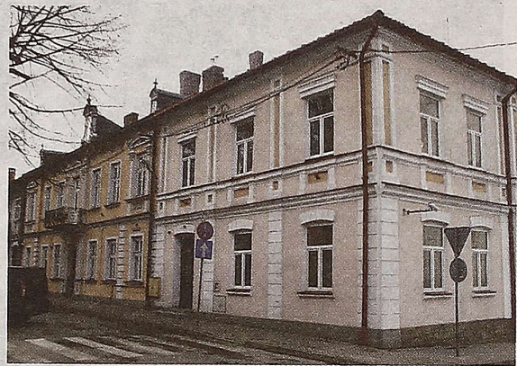
Budynek, w którym mieści się Sąd Rejonowy w Lesku
