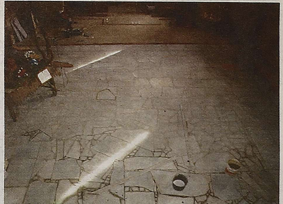
Ułożona posadzka w nawie
