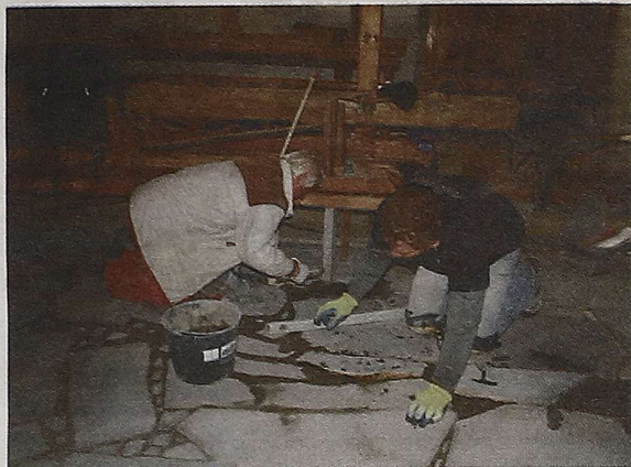
Ekipa posadzkarzy przy pracy
