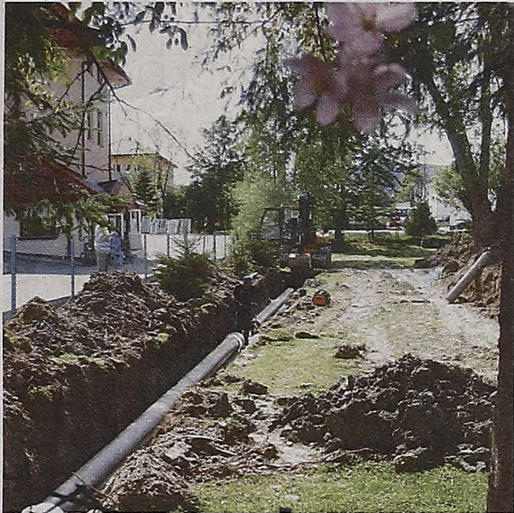
Budowa ostatniego odcinka nowej nitki ciepłociągu jest już mocno zaawansowana Fot. T. Szewczyk
