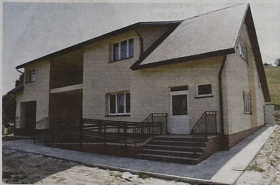
Takiego domu ludowego mieszkańcom Rudenki może pozazdrościć niejedna bieszczadzka wioska Fot. UG Olszanica
