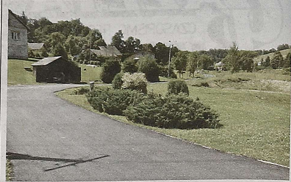
Odbudowana droga w Rudence
