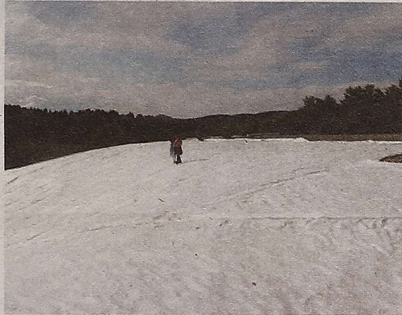
Podczas jednego z etapów rekultywacji przykryte geowłókniną wysypisko wyglądało jak lodowiec w Alpach
