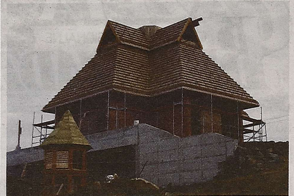
Niedługo budowlę zwieńczy wieżyczka i rozpocznie się krycie dachu blachą tytanową Fot. T. Szewczyk
