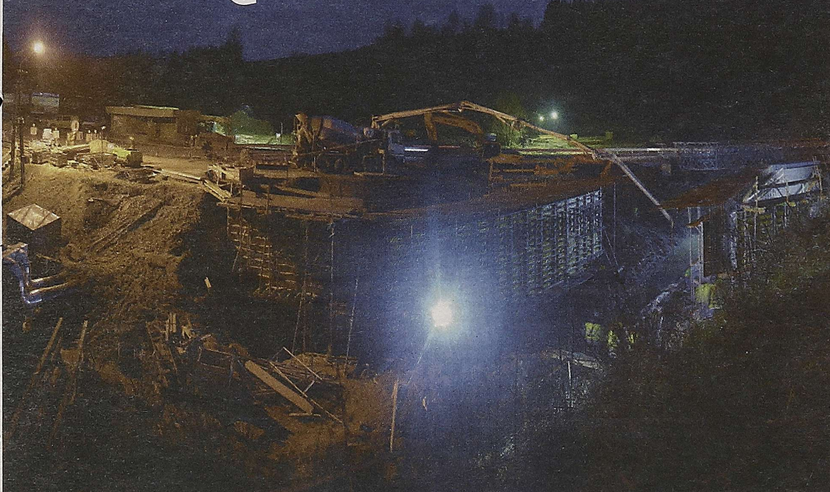
Przebudowa mostu na Równiance idzie w dobrym tempie
