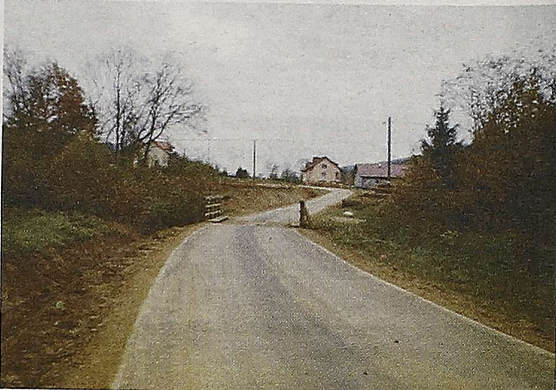
Remont zaplanowanego na ten rok odcinka drogi w Zawadce został zakończony Fot. A. Krystian
