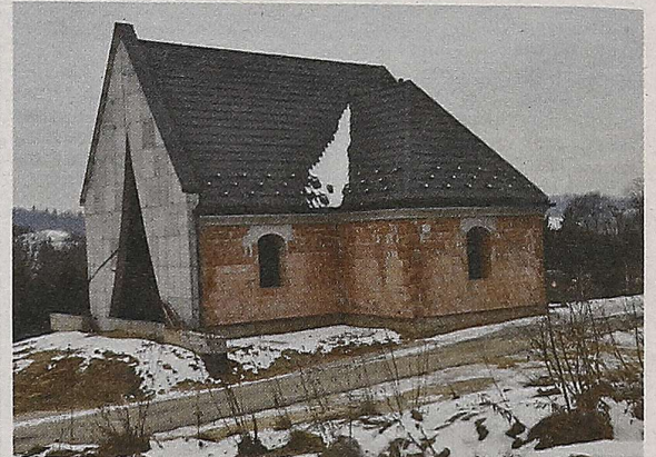
Budowa kaplicy osiągnęła stan surowy otwarty
