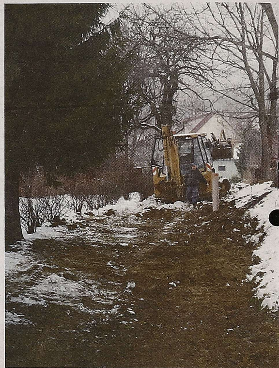
Budowa zaplanowanego odcinka kanalizacji przy ul. Nadgórnej już się rozpoczęła. Fot. T. Szewczyk
