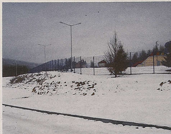
Zestawy kolektorów słonecznych zostaną rozmieszczone na skarpie poniżej basenów odkrytych Fot. T. Szewczyk
