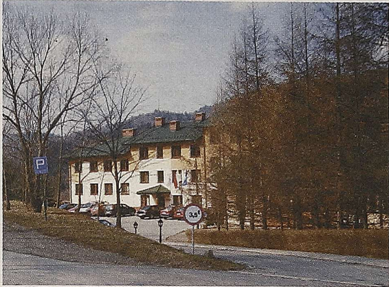
W siedzibie Nadleśnictwa Cisna kotłownia na biomasę zastąpi kotłownię olejową Fot. T. Szewczyk
