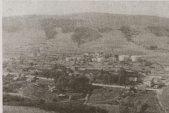
Ustrzycka rafineria w czasie okupacji niemieckiej pracowała na pełnych obrotach (widok z 1938 r.) Fot. ze zb. J. Michałowskiego
